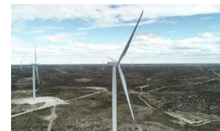
Cañadón León Wind Farm, 123 MW.
