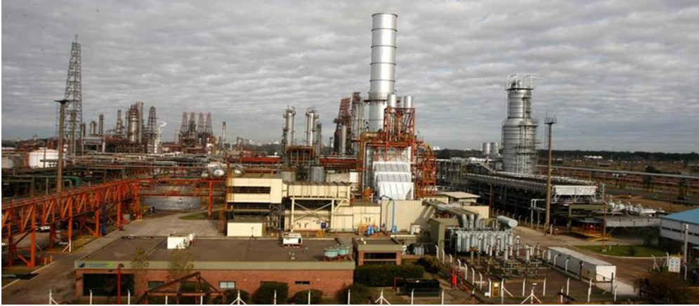
La Plata Cogeneración
