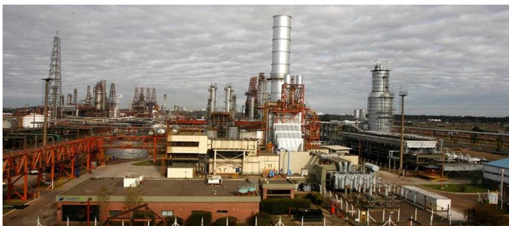
La Plata Cogeneración
